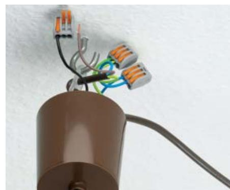
Петлевое подключение осветительного прибора гибкими проводниками.
