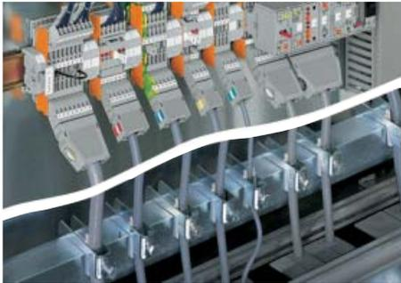
Кабельные вводы в нижней части электрических шкафов, индивидуальные электрические пластины для каждого кабеля, уплотнение губчатыми резиновыми полосками на выдвижном полу шкафа, обеспечивающее степень защиты IP 54 (например, от фирмы Rittal)
