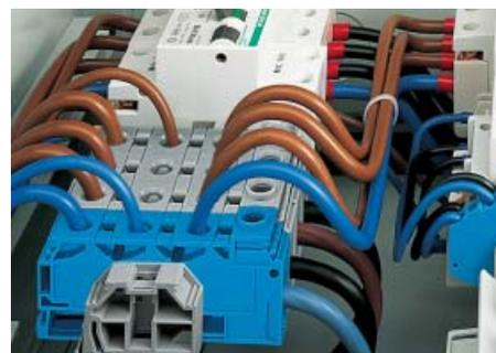
Распределительные клеммы на DIN-рельс с винтовым зажимом на 35 мм<sup>2</sup> (боковой электромонтаж) и 3 зажимами CAGE CLAMP по 10 мм<sup>2</sup> (фронтальный электромонтаж). Клеммы закрыты с обеих сторон, боковые и концевые пластины не нужны.
