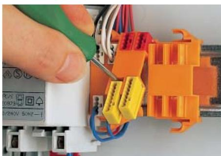
Демонтаж клеммы с кронштейна
