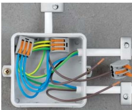
Подключение гибких проводников в распределительной коробке
